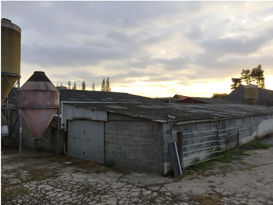
Figure 4. Photographies des installations avant démolition (Source : DMB Conseil)
